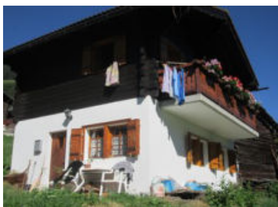
Façades est et sud
