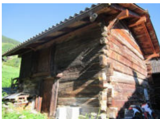
Façades est et sud
