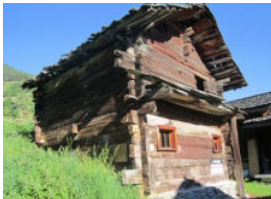
Façades est et sud
