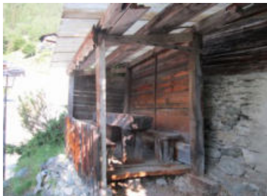
Façade avant et est
