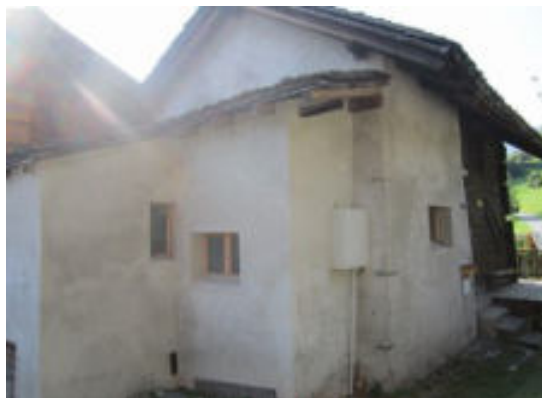
Façades nord et ouest
