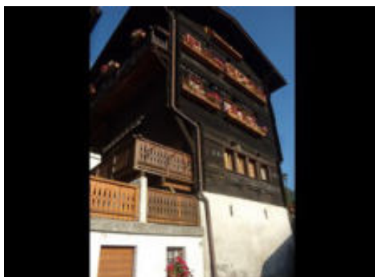
Façades est et sud
