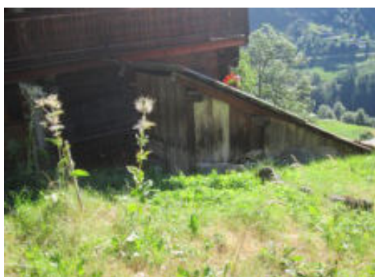
Façades nord-ouest et sud
