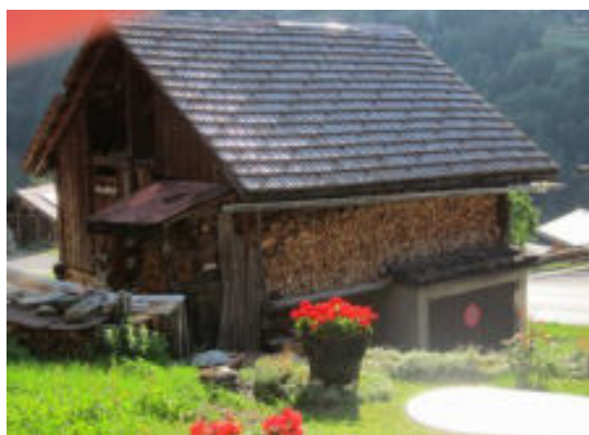
Façades nord-ouest et sud-ouest
