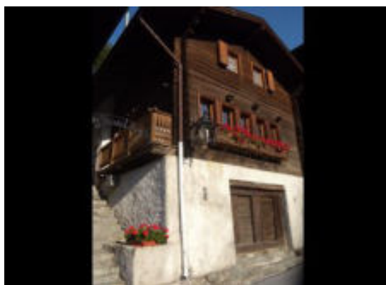
Façades est et sud
