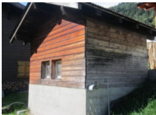
Façades est et nord-ouest
