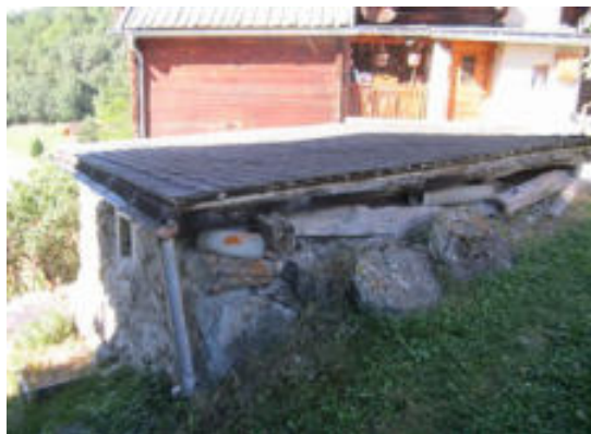
Façade avant et toit
