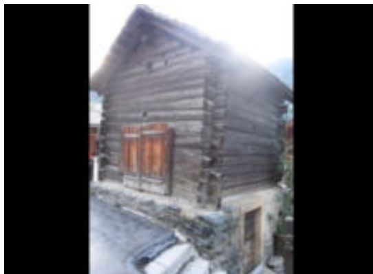
Façades nord-ouest et sud
