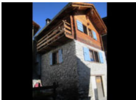
Façades sud et est
