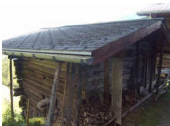
Façades sud et sud-ouest
