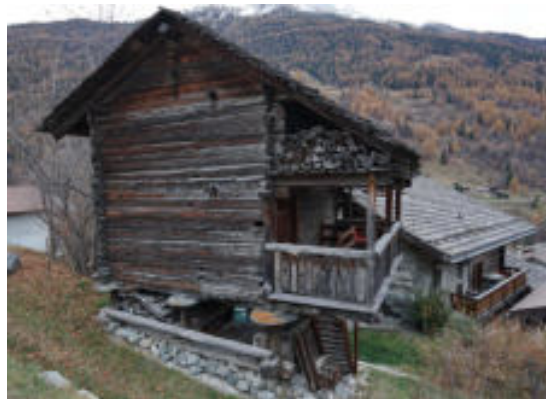
Façades nord-ouest et sud-Ouest
