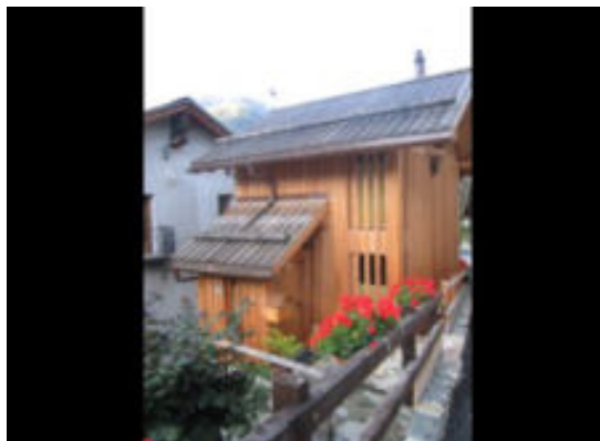
Façades nord-ouest et nord-est
