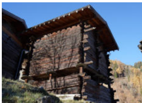
Façades nord-est et sud-est
