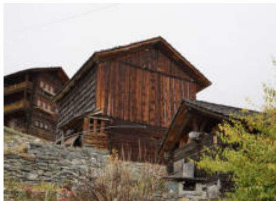
Façades Sud-Est et Sud-Ouest
