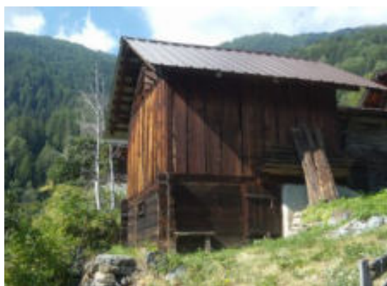
Façades nord-est et sud-est
