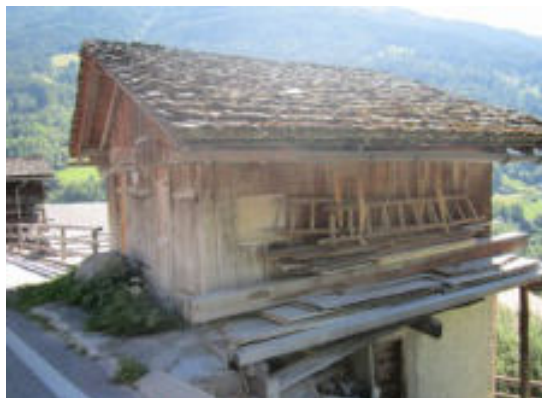
Façades nord-ouest et sud-ouest
