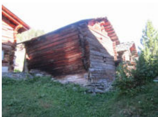
Façades est et sud
