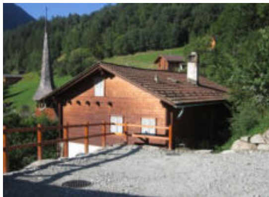
Façades nord et est
