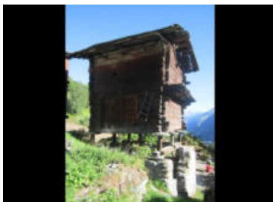
Façades sud et est
