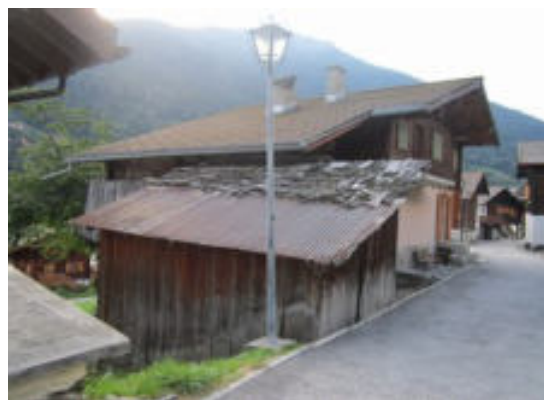
Façades sud-ouest et nord-ouest
