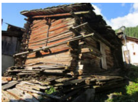
Façade est et nord
