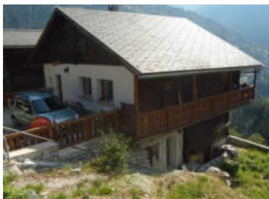
Façades nord-ouest et sud-ouest
