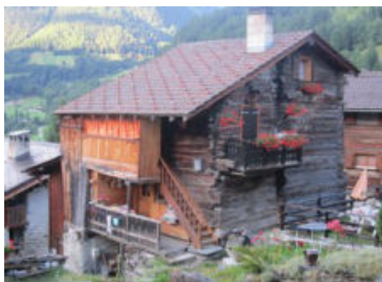
Façades nord-est et nord-ouest
