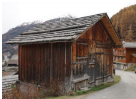
Façade Nord-Est et Nord-Ouest
