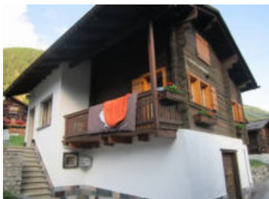
Façades nord-est et sud-est
