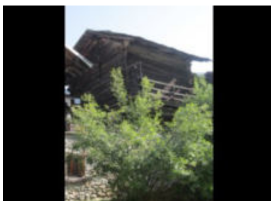
Façades sud et ouest
