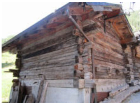
Façades nord et est
