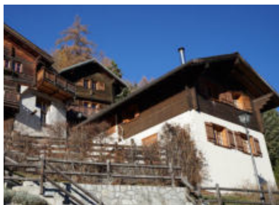
Façades est et Sud
