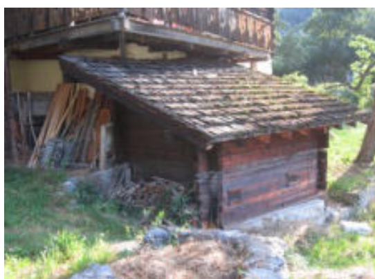
Façades sud et ouest
