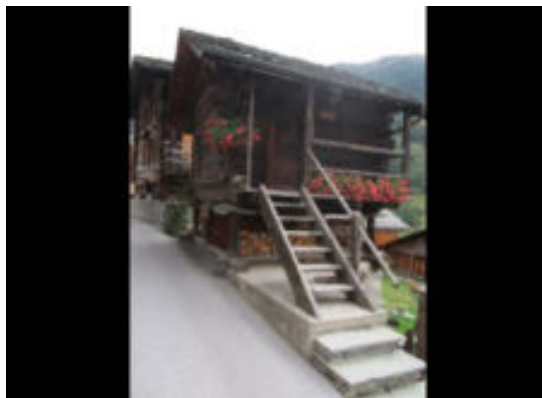
Façades sud-ouest et nord-ouest
