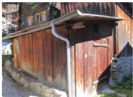
Façades sud et sud-ouest
