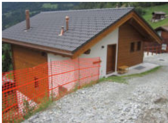
Façades nord-est et nord-ouest
