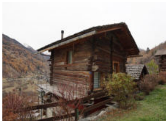
Façades Nord-Est et Nord-Ouest
