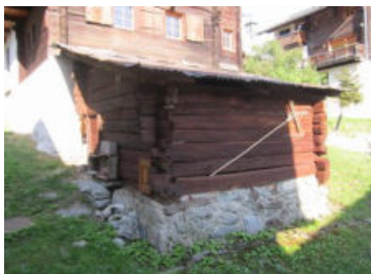
Façades est et sud
