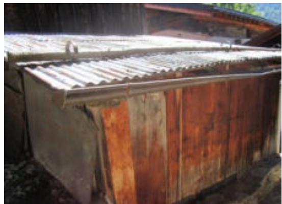
Façade sud-ouest et toit
