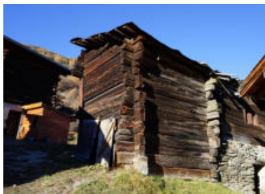
Façades sud et est
