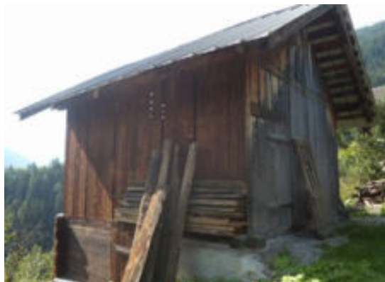
Façades nord-est et nord-ouest
