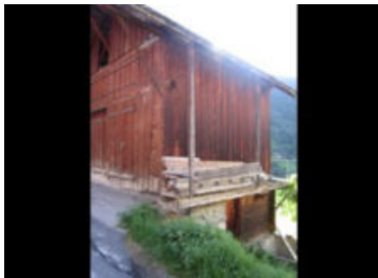
Façades nord-ouest et sud-ouest
