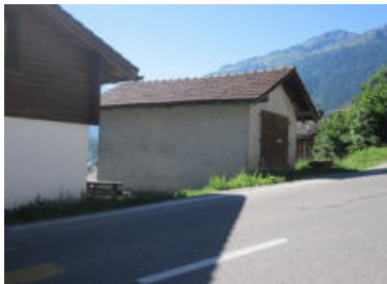
Façades nord-ouest et nord
