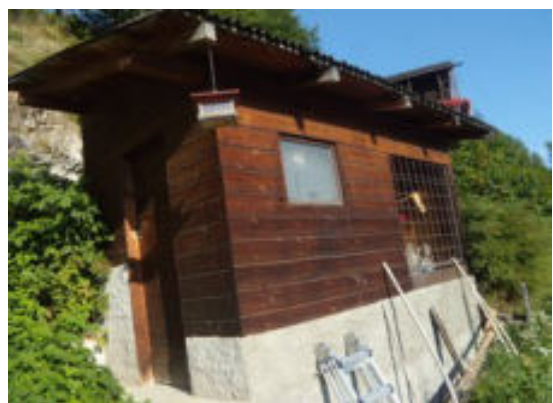
Façades est et sud
