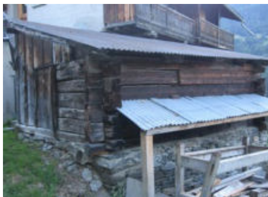
Façades sud-ouest et nord-ouest
