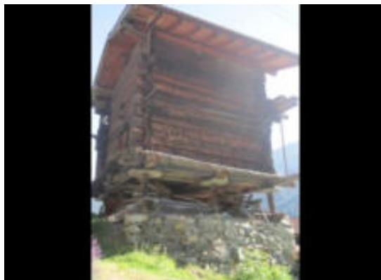
Façades nord-ouest et sud
