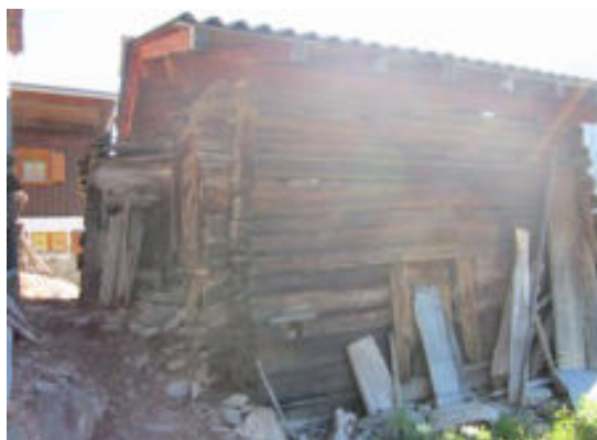
Façades nord-ouest et sud
