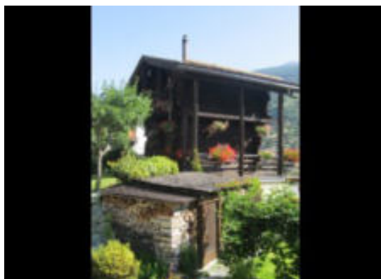
Façade ouest et toit
