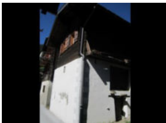
Façades sud-est et nord
