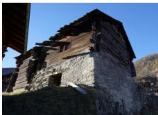
Façades nord et est
