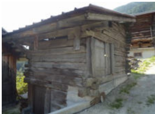
Façades nord-ouest et nord-est
