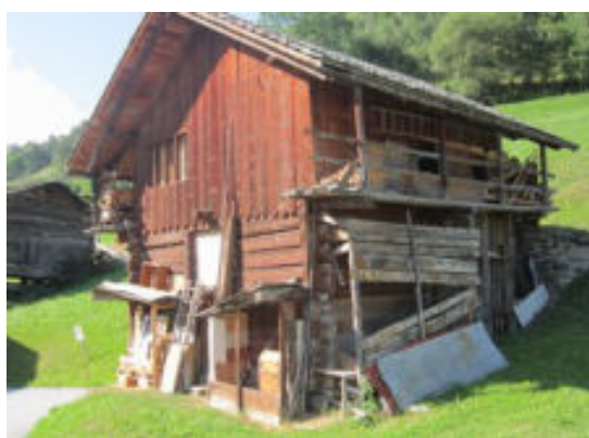
Façades est et nord-ouest
