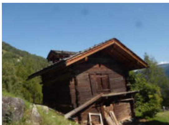
Façades sud-est et sud-ouest
