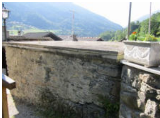
Façade nord et toit
