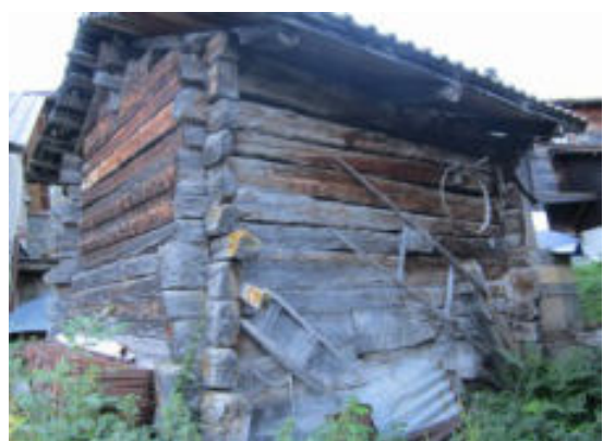
Façades nord-est et nord
