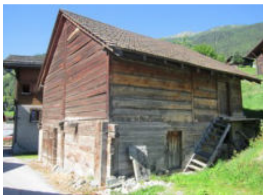
Façades sud-est et nord
