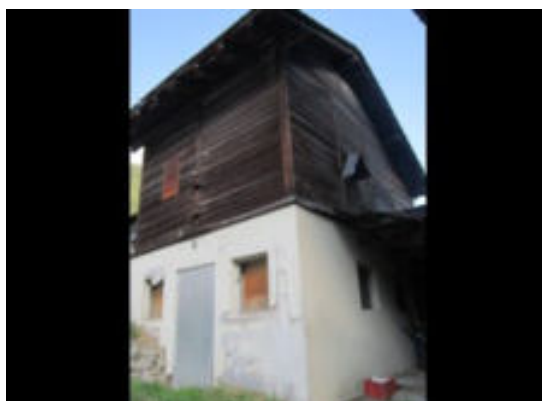
Façades nord-est et sud-est
