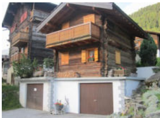
Façades nord-est et nord-ouest
