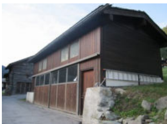
Façades nord-est et nord-ouest
