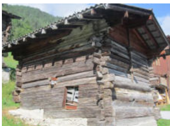
Façades nord-est et sud-est
