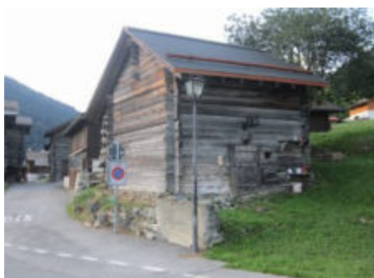
Façades nord-est et nord-ouest
