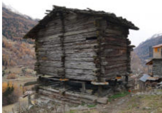
Façades Nord et Ouest
