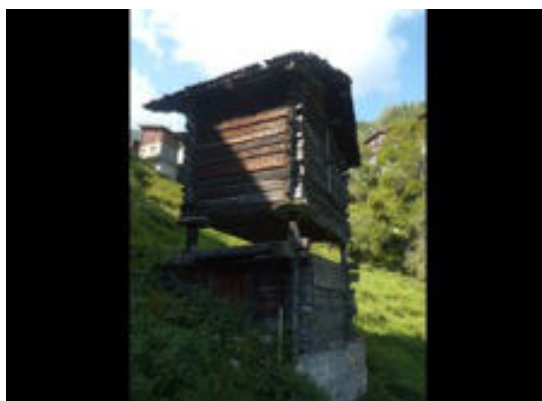
Façades est et nord
