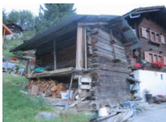
Façades est et sud
