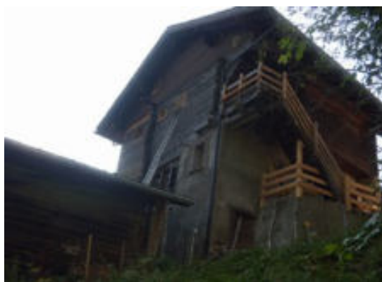
Façades nord-ouest et sud-ouest
