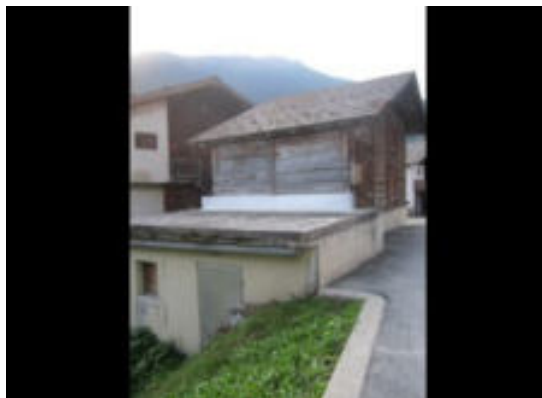
Façades sud-ouest et nord-ouest
