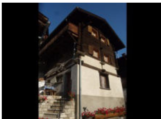
Façades est et sud
