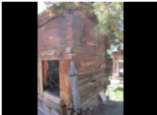
Façades nord-ouest et nord-est
