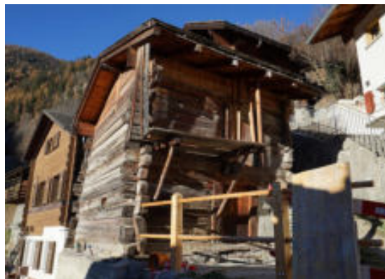
Façades nord-est et sud-est
