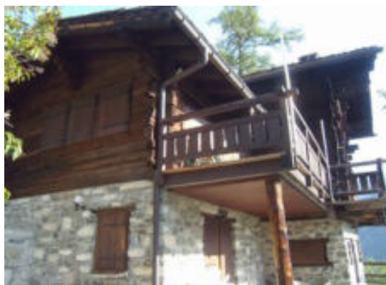
Façades sud-est et sud-ouest
