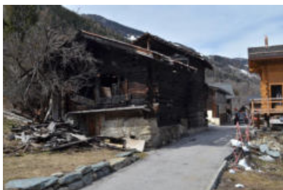
Façade sud-est et nord-est
