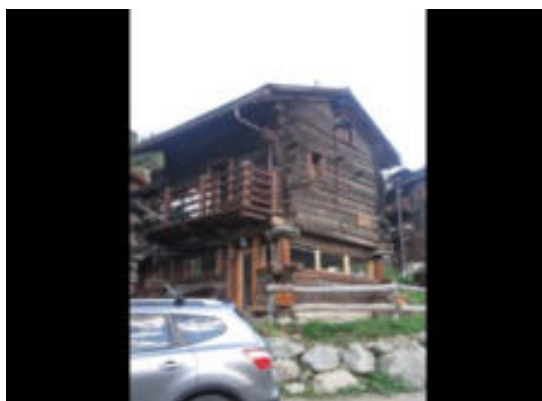
Façades est et sud
